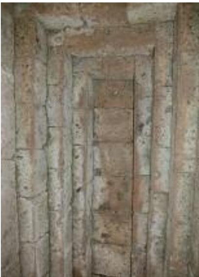
Fig. 24 - Cerveteri. Soffitto del *dromos* della Tomba dei Capitelli. Esempio di copertura a falsa volta.
