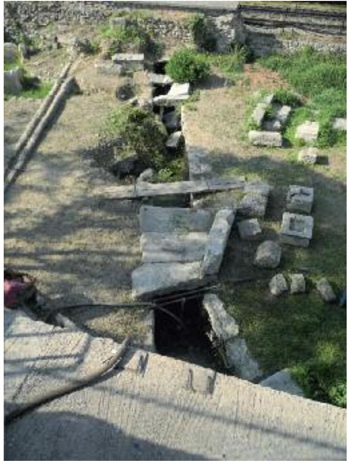
Fig. 23 - Atene. Il canale coperto sottostante la pavimentazione dell'Agorà, in prossimità della Stoà di Attalo (Foto E. Bianchi).
