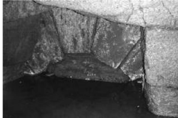
Fig. 52 - Cloaca Massima sotto l'Arco di Giano. Lo sbocco del canale, raffigurato dal Merckel nella sezione della Fig. 51. Si tratta di un canale preesistente, certamente modificato, allacciato al condotto contemporaneo alla costruzione dell'Arco di Giano e poi tamponato in età non precisabile (Foto E. Bianchi).
