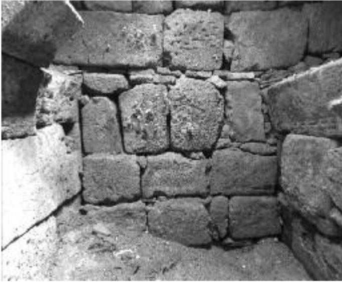
Fig. 3 - Il canale defunzionizzato sottostante la Basilica Emilia. La tamponatura visibile dall'interno del canale verso il Foro di Nerva (Foto E. Bianchi).
