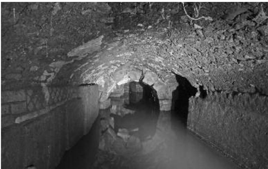
Fig. 10 - Il tratto rettilineo della Cloaca Massima sotto il Foro Romano visto da sud. Sul fondo lo sbocco del canale sottostante la Basilica Emilia; a destra, lo sbocco del condotto della via Sacra (Foto E. Bianchi).
