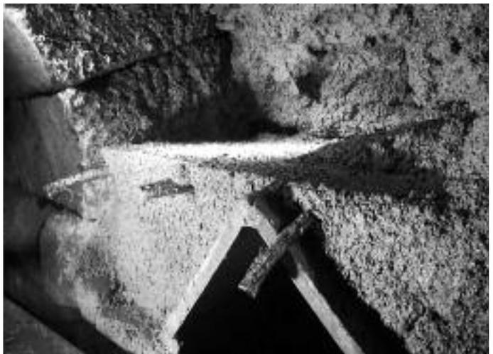
Fig. 54 - *A sinistra*, un crollo verificatosi nel tratto di condotto rappresentato nella Fig. 53 nell'aprile del 2013 che ha interessato la sponda e la volta del condotto (Foto E. Bianchi). *A destra*, la fase del restauro nella porzione interessata dal crollo che ha riguardato il ripristino della cappuccina e della porzione di volta soprastante (Foto R. Di Petrillo).
