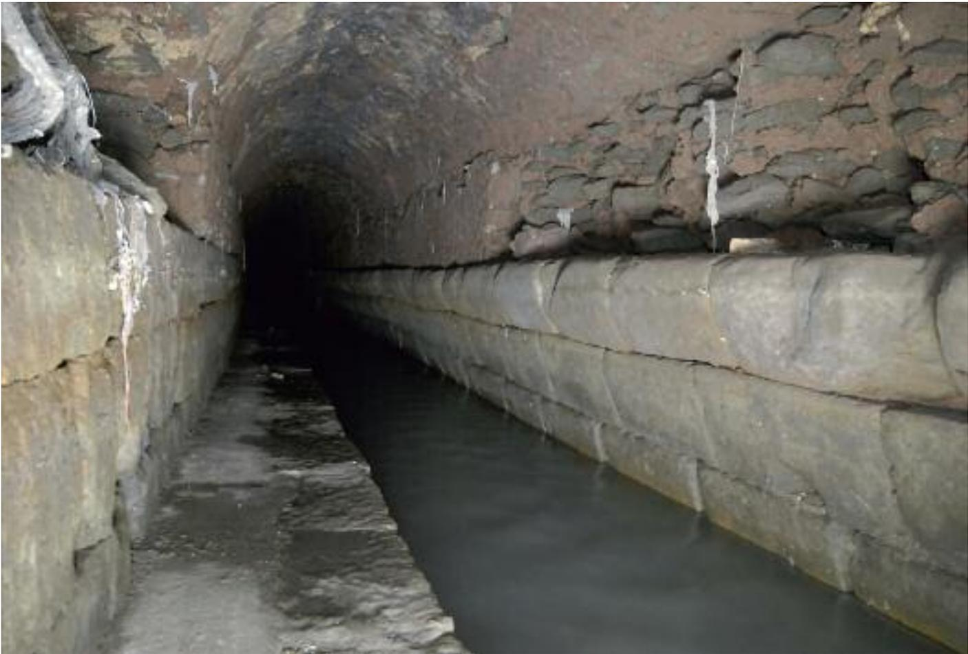
Fig. 17 - Il tratto centrale della Cloaca Massima sotto il Foro Romano corrispondente al canale orientale del sistema di drenaggio di età regia (Foto E. Bianchi).
