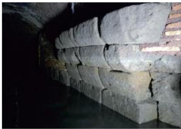
Fig. 19 - Il canale orientale del sistema di drenaggio di età regia. Particolare dei filari di blocchi di cappellaccio (Foto E. Bianchi).
