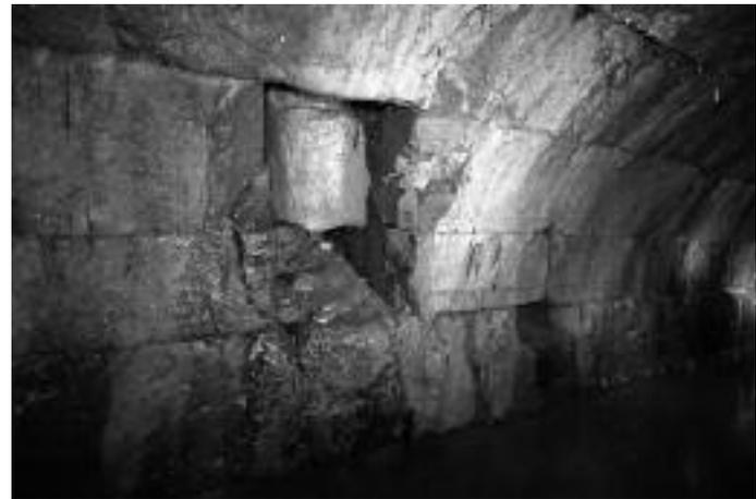
Fig. 45 - Frammenti architettonici visibili dall'interno di un pozzo presente nella volta della Cloaca Massima al di sotto dell'incrocio tra via dei Fienili e via Bucimazza (Foto E. Bianchi).
