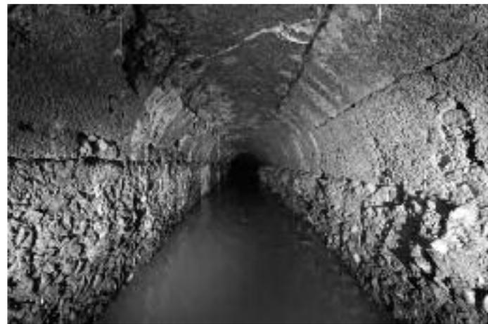
Fig. 37 - La Cloaca Massima nel secondo tratto del gomito che il condotto forma al di sotto del *Vicus Tuscus*. Si noti qui la struttura interamente realizzata in conglomerato cementizio (Foto E. Bianchi).
