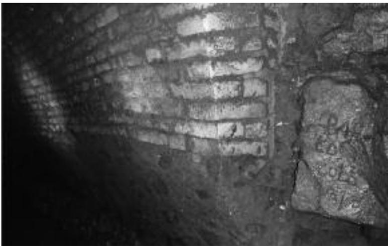
Fig. 42 - La Cloaca Massima sotto via dei Fienili. L'aggancio tra la muratura di restauro e il canale in opera quadrata di tufo. Sulla destra il blocco recante l'iscrizione (Foto E. Bianchi).
