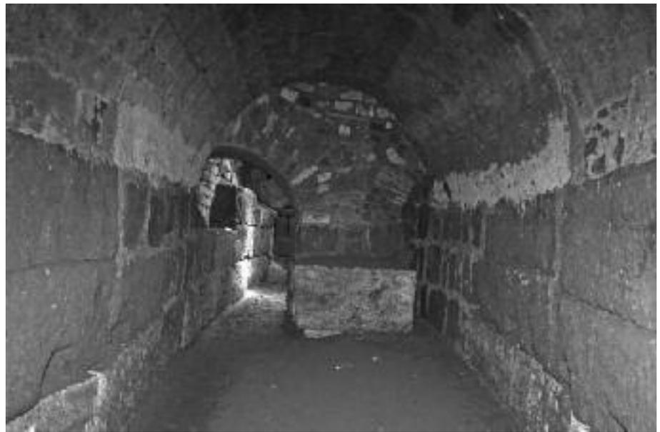
Fig. 4 - Il canale sottostante la Basilica Emilia con la fondazione di una colonna della navata superiore. *A sinistra*, durante lo scavo di G. Boni (Archivio Fotografico SSBAR); *a destra*, allo stato attuale con la copertura realizzata da G. Boni (Foto E. Bianchi).
