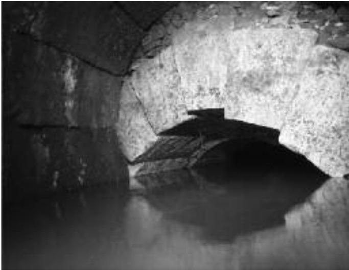
Fig. 48 - Il punto di congiunzione tra il tratto di Cloaca Massima proveniente da monte (sul fondo) e il braccio realizzato *ex novo* con la costruzione dell'Arco di Giano (Foto E. Bianchi).
