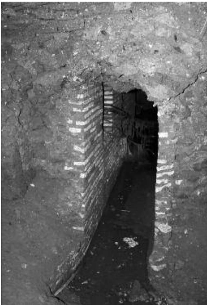
Fig. 8 - Basilica Emilia, scavo Boni. Il tratto di Cloaca Massima passante sotto le navate con il piano di scorrimento pavimentato in lastre di travertino (Archivio Fotografico SSBAR).
