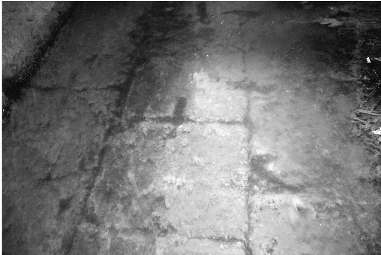
*Cloaca Massima di età domiziana. Particolare della pavimentazione in lastre di travertino*
