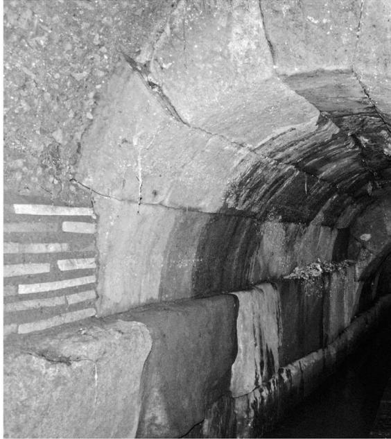
*Fig. 1. Tratto terminale della Cloaca Massima domiziana verso ovest. Particolare dell'innesto della volta in calcestruzzo con il tratto realizzato in blocchi tra la Curia e la Basilica Emilia*
