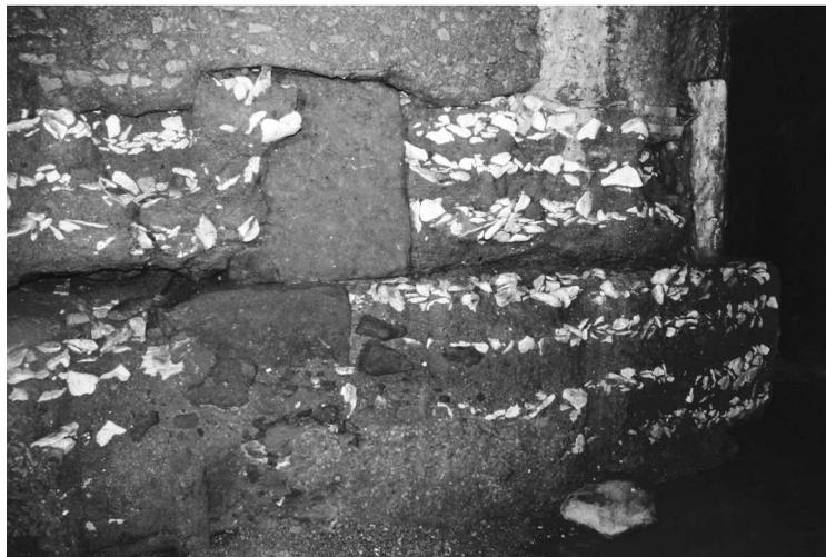
Fig. 2. *Cloaca Massima* di età vespasiana. Particolare della fondazione in calcestruzzo e blocchi di tufo
