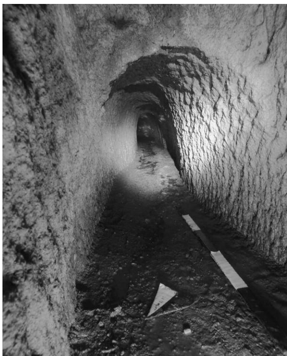
Fig. 9. Roma, galleria sotto la via Flaminia: interno di un cunicolo parallelo alla galleria, verso est. Sono visibili sulle pareti le tracce di scavo.
