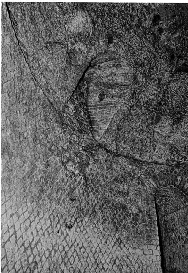
92. Torricella. Apertura tamponata e fori sulla volta.
