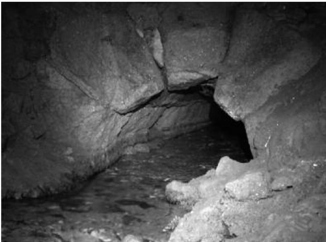
Fig. 4 - Ghiera esterna della volta del collettore del *Clivus Suburanus* formata da conci di Cappellaccio.
