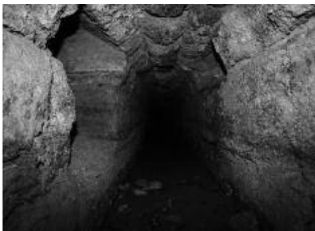
Fig. 8 - Adduzione laterale del collettore ricavata nello spessore dei conci strutturali.
